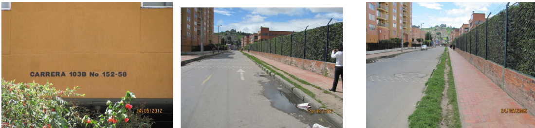
Vista general de obligación establecida sobre la Calle 152ª (V-7)
